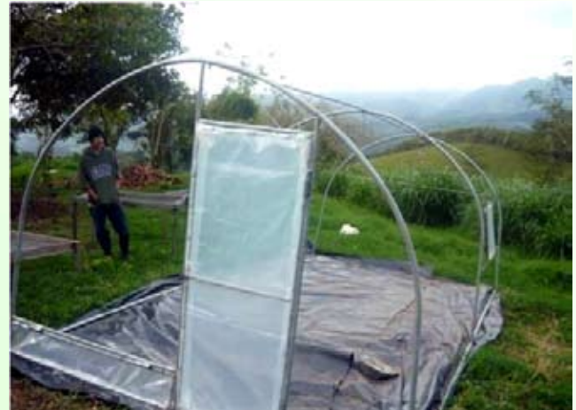
Estructura del secador metálica
